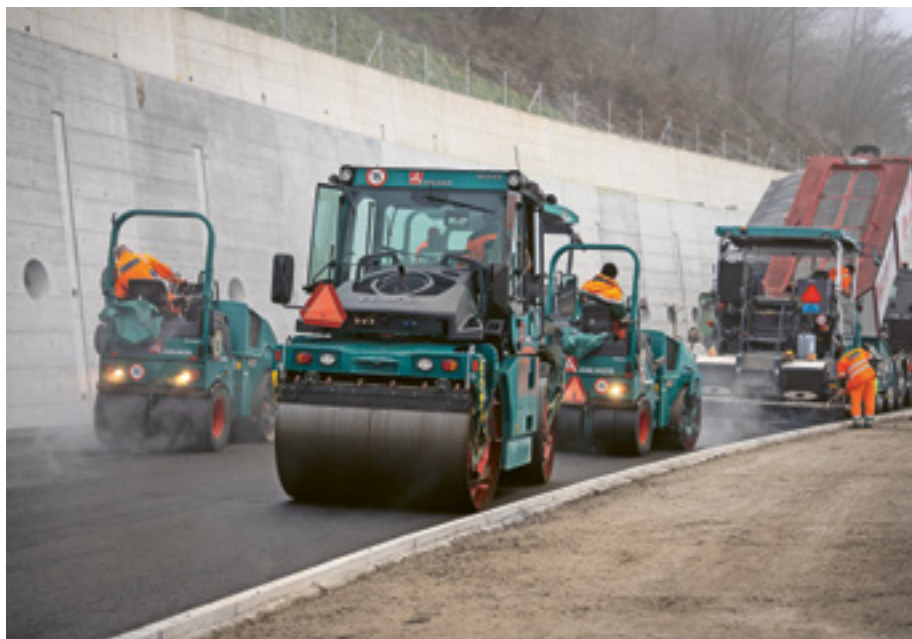
Schweres Gerät kommt zum Einsatz.
