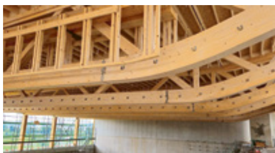
Juni 2024: Die imposanten Fachwerkträger werden gesetzt (oben).
