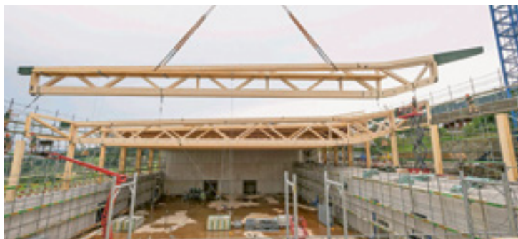
Juni 2024: Die imposanten Fachwerkträger werden gesetzt (oben).
