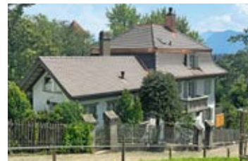
Steildachsanierung am Schirmertorweg direkt an der Museggmauer.
