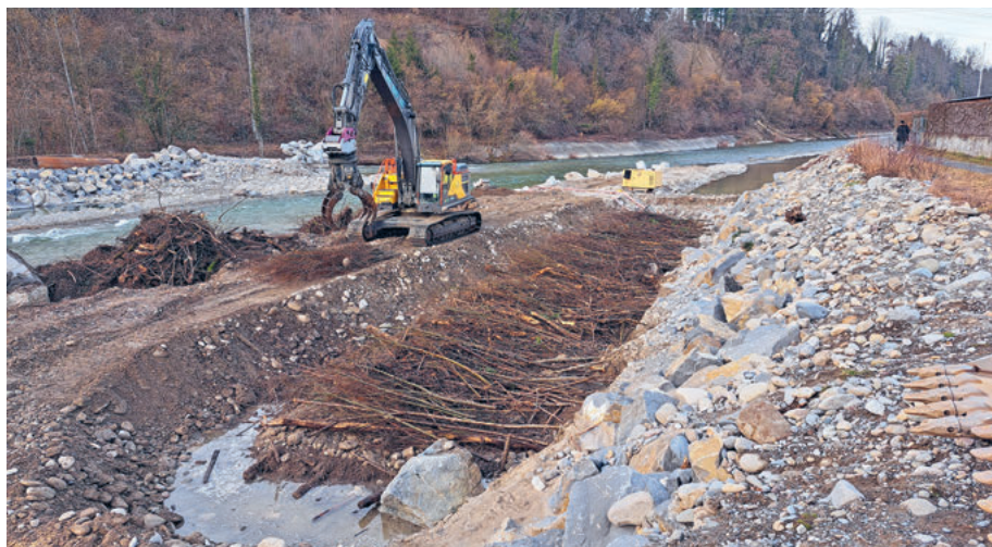
Bauarbeiten am Los 1.
