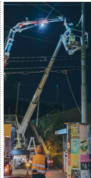
Baustelle Masten: Installation der Fahr- leitungsmasten, an denen die Fahrleitung befestigt wird, wenn keine Verankerung an Gebäuden möglich ist.
