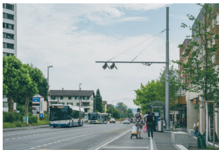
Die fertiggestellten neuen Stützladner (links und oben rechts).
