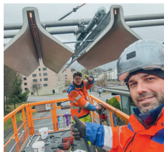
Mitarbeiter aus dem VBL-Team Fahrleitung: vorne Agron Ejupi, Mitarbeiter Fahr- leitung, und hinten Marc Schmocker, Mitarbeiter Fahrleitung.
