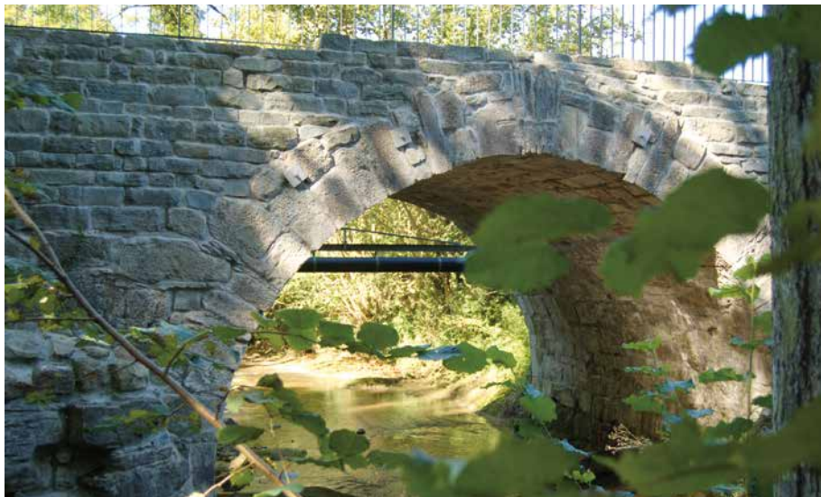
Die Römerbrücke über den Rotbach wurde unlängst saniert. auch sie erinnert an die ehemalige wichtige Landstrasse.
